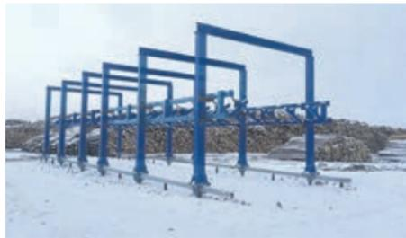
В Виноградовском леспромхозе на территории терминала близится к завершению монтаж эстакады для снятия перехватов. Это устройство позволит осуществлять безопасную и безаварийную разгрузку сортировозов с лесом. На новом объекте будет установлено электронное табло для считывания кубатуры лесовозов, которые заходят на терминал.
